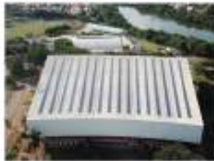
Figura 1 – Planta de Energia Solar Fotovoltaica do Gênio Multidisciplinar da Unicamp.
